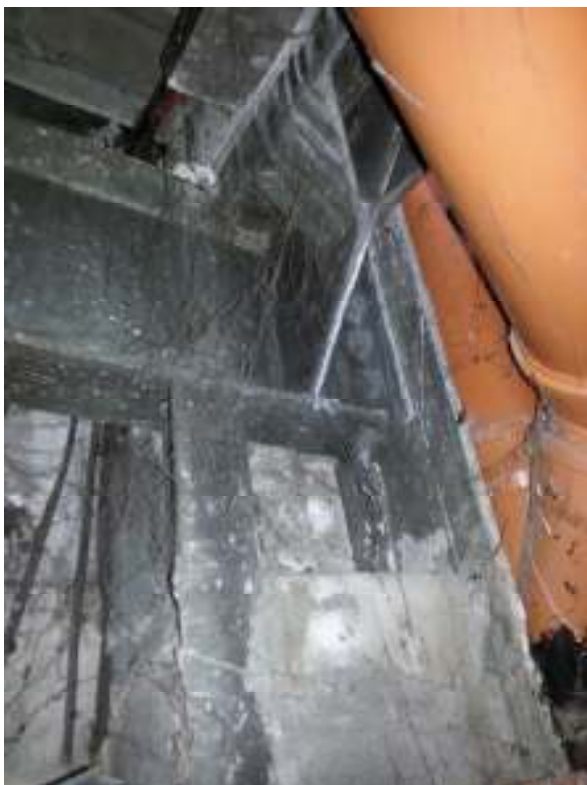
Układ konstrukcyjny zadaszzenia części zaplecza (niższej). Widoczny układ płatwi oraz blachy fałdowej.
