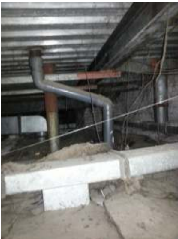
Układ konstrukcyjny zadaszzenia części zaplecza (niższej). Widoczny układ płatwi oraz blachy fałdowej.
