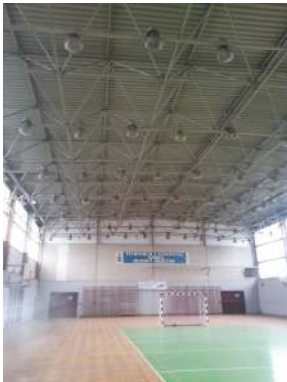
Widok kratownicy przestrzennej nad częścią sali wraz z konstrukcją główną oraz ścianą szczytową.
