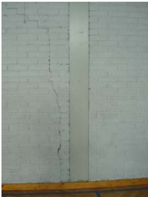
Zarysowanie części murowanej ścian wypełniających ściany szczytowej.
