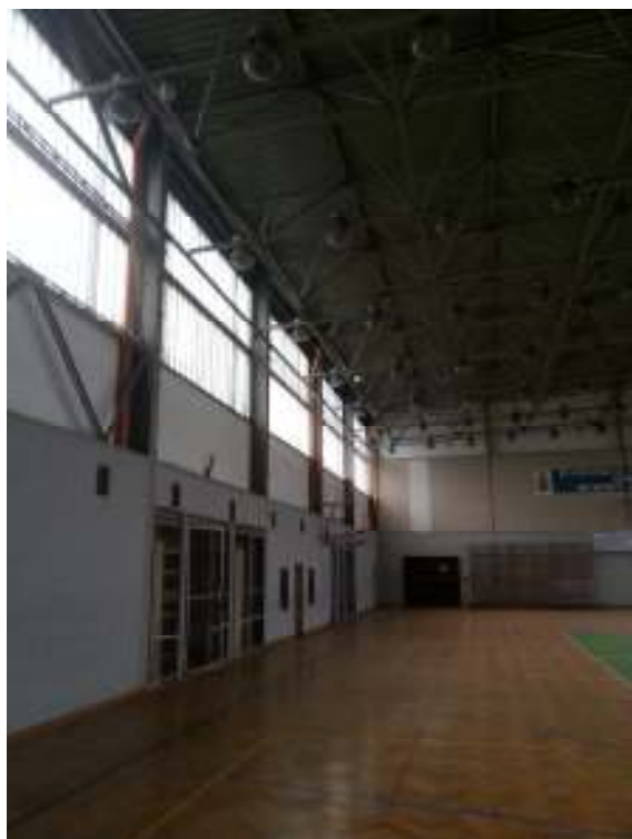
Widok kratownicy przestrzennej nad częścią sali wraz z konstrukcją główną oraz ścianą szczytową.
