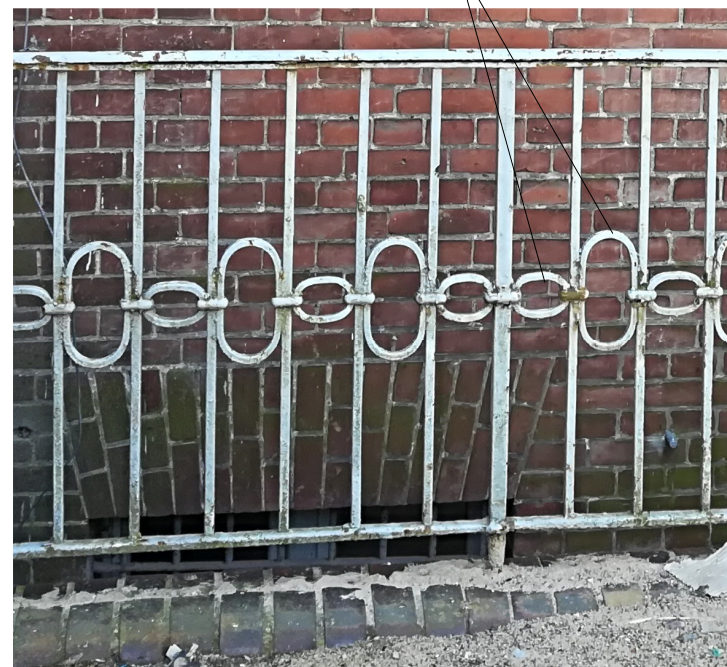
ELEMENTY DEKORACYJNE PROJEKTOWANEJ BALUSTRADY - NA WZÓR ISTNIEJĄCEJ
