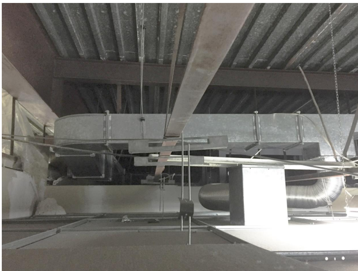
fot.2 Zdjęcie z natury –widok kształtu blachy trapezowej oraz sufitu podwieszanego z płyt włóknowych
