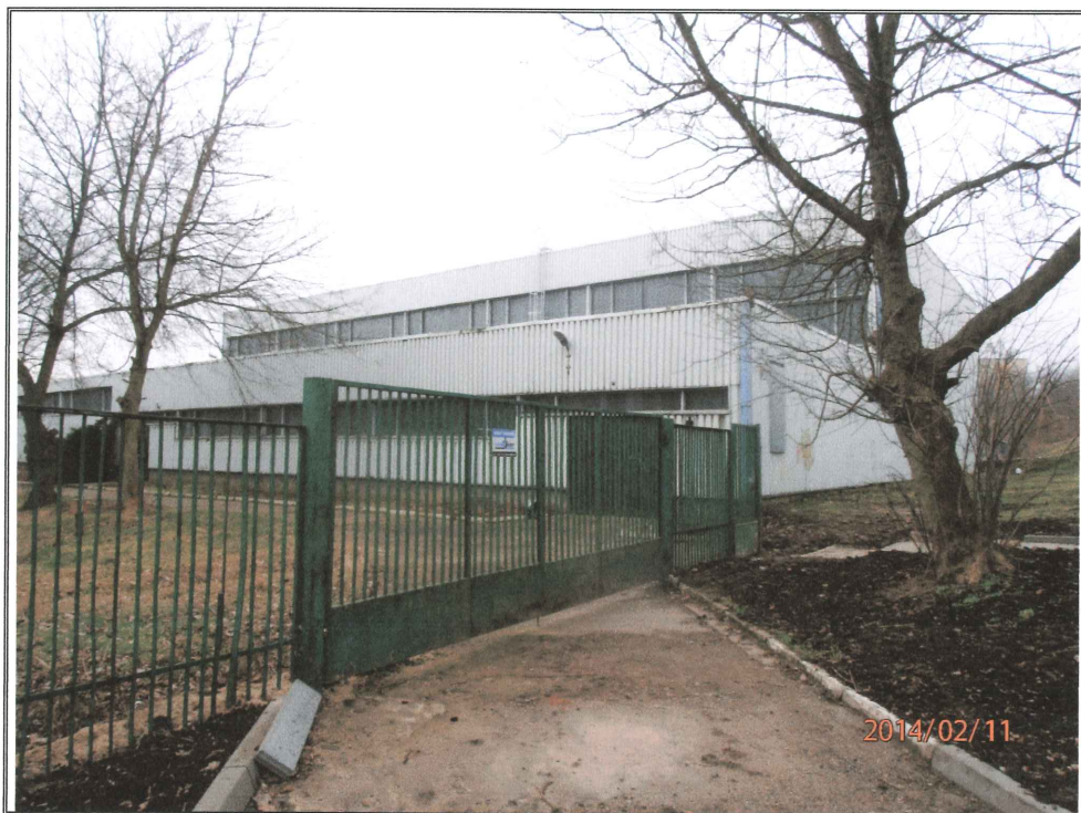
Zdjęcie nr 43. J. w. lecz widok hali sportowej od strony północno - wschodniej.
