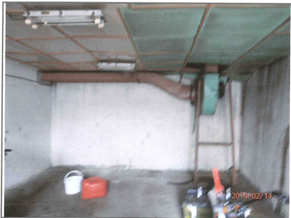
Zdjęcie nr 22. J. w. lecz widok wnętrza jednego z pomieszczeń krajalni.
