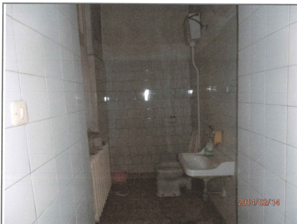
Zdjęcie nr 40. J. w. lecz widok jednej z ubikacji w piwnicy.
