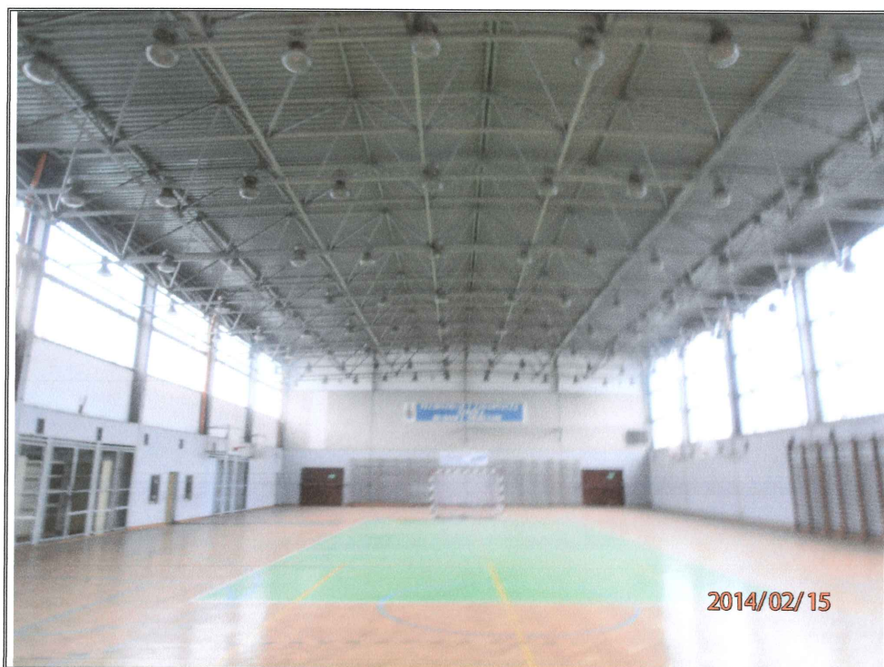
Zdjęcie nr 47. J. w. lecz widok fragmentów wnętrza hali sportowej. Widok sali gimnastycznej.
