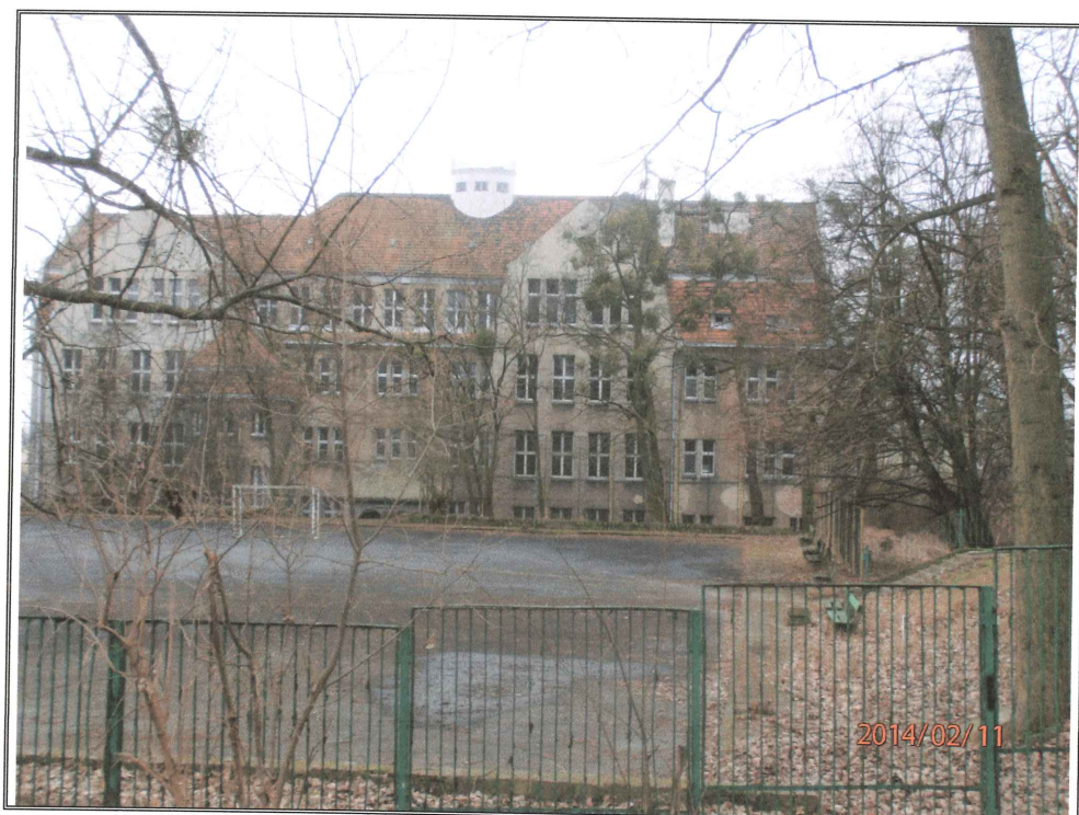
Zdjęcie nr 28. J. w. lecz widok budynku starej szkoły od strony północnej. Przed budynkiem boisko szkolne i ogrodzenie z prętów stalowych.
