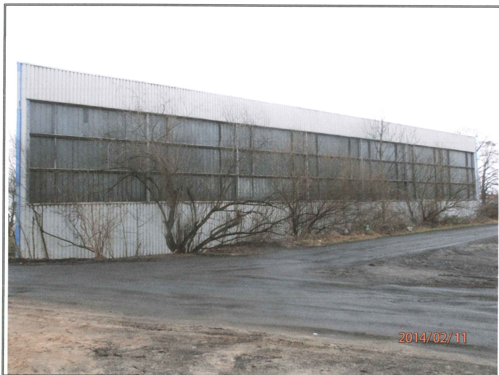
Zdjęcie nr 44. J. w. lecz widok hali sportowej od strony zachodniej.
