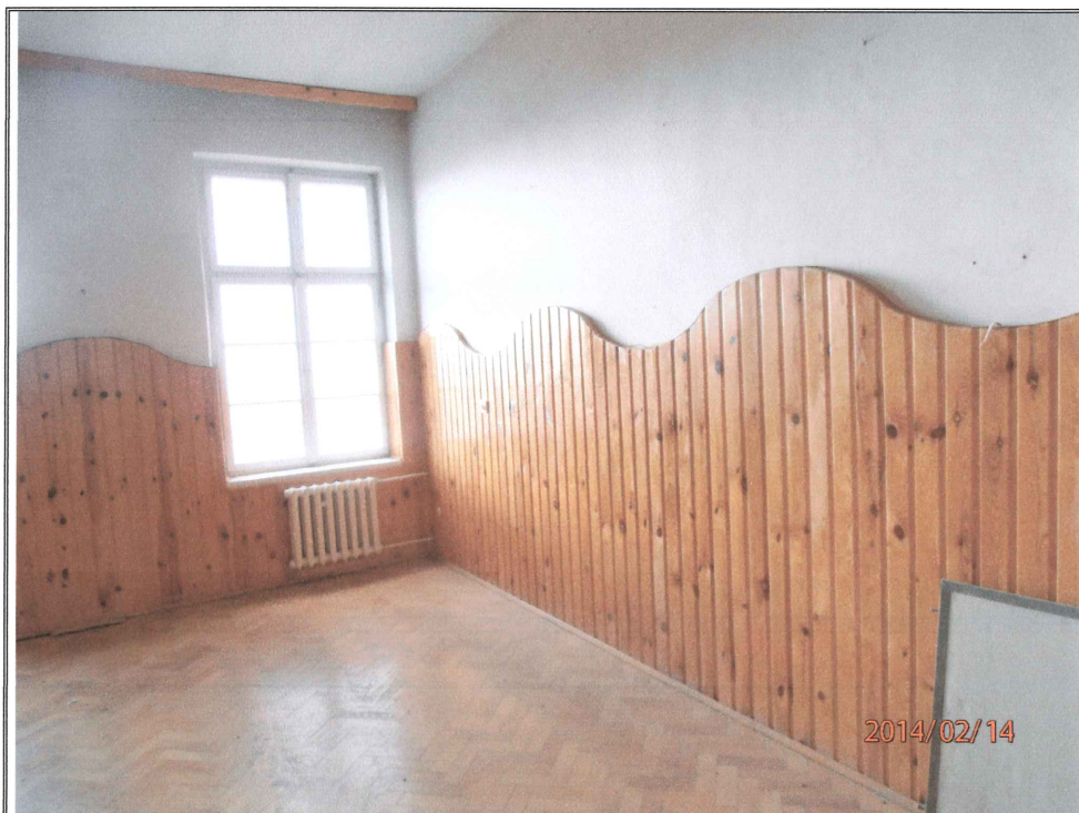
Zdjęcie nr 13. J. w. lecz fragment pomieszczenia biurowego.
