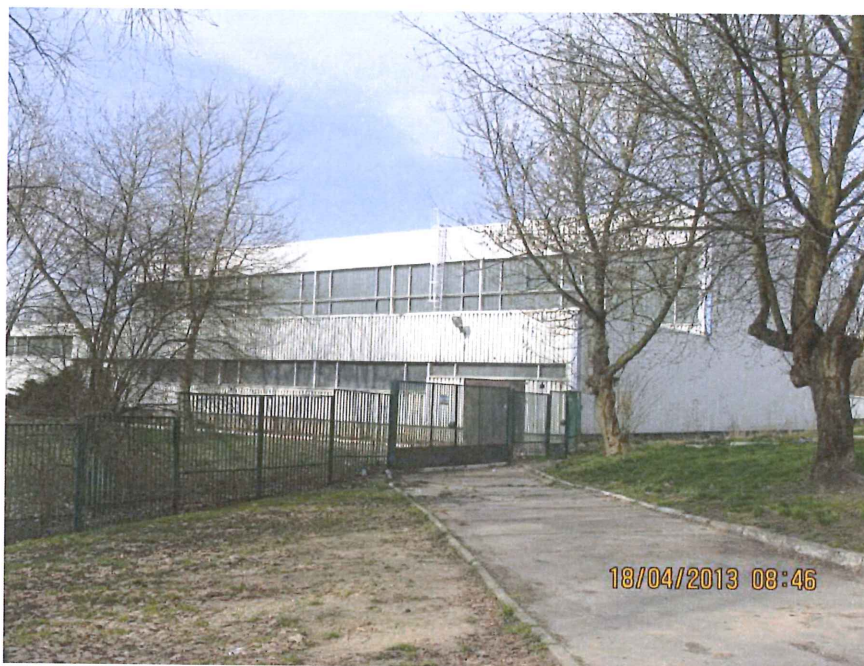
Fotografia nr 5. Budynek sali sportowej od strony ulicy Rugiańskiej.
