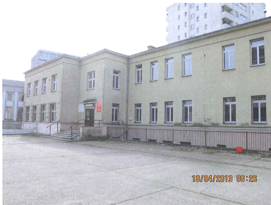
Fotografia nr 2. Budynek dydaktyczny nr 1 widok od strony dziedzińca .
